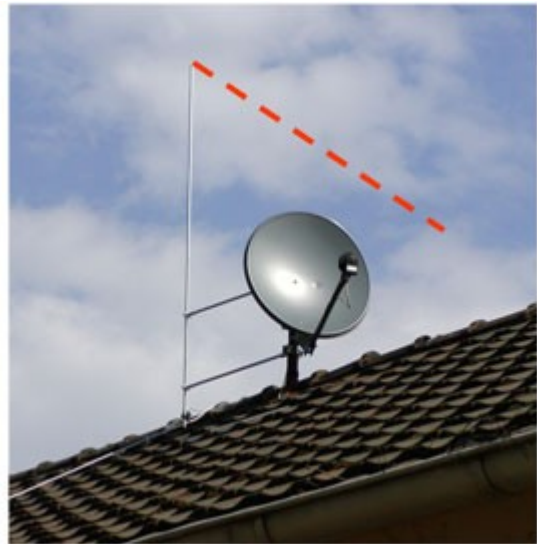
Bild 9: Satellitenschüssel mit getrennter Fangeinrichtung
